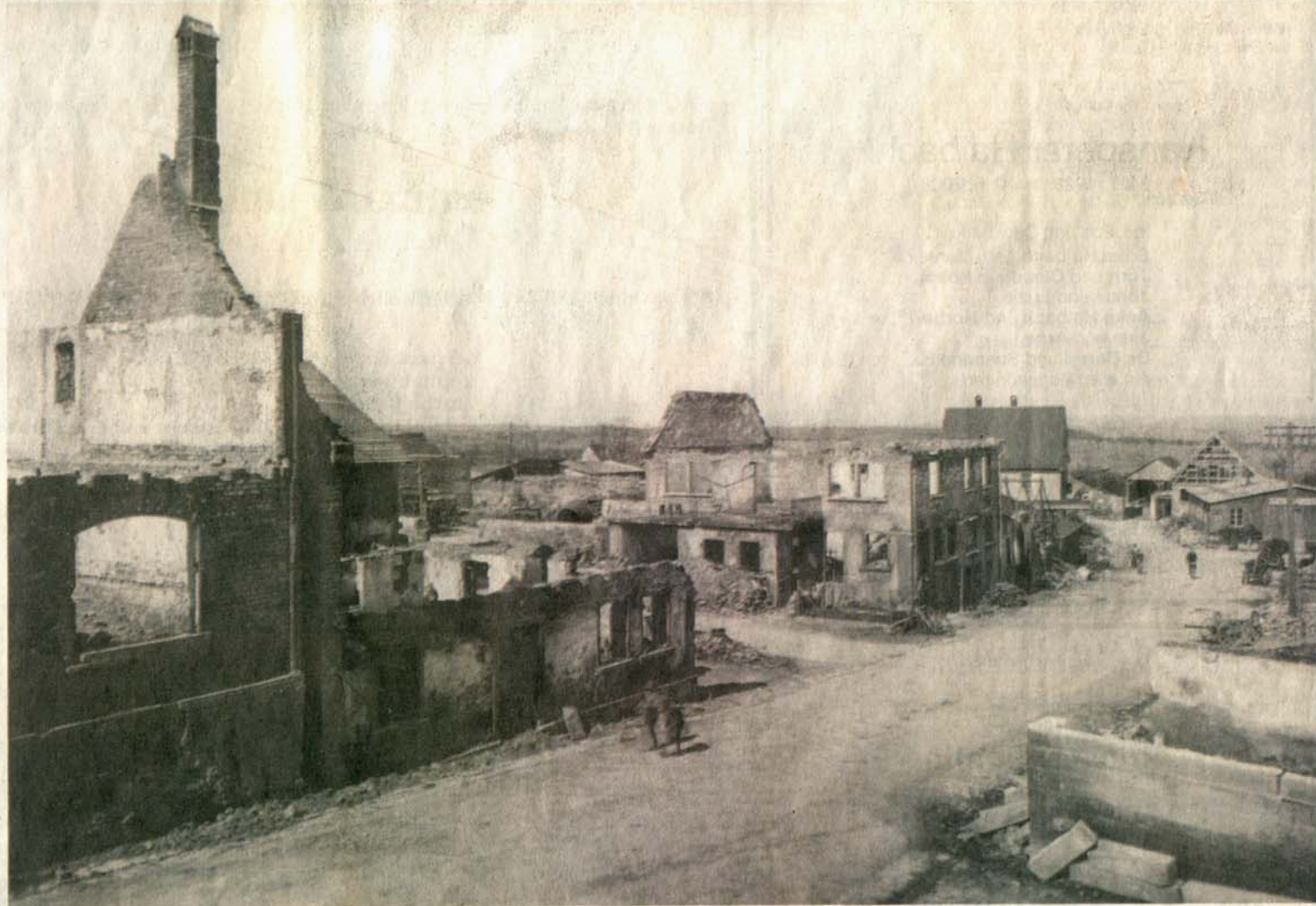
309 von 447 Gebäuden liegen in Schutt und Asche, doch die Aufbauarbeiten sind bereits im Gang: Nussdorf am Ende des Zweiten Weltkriegs.
